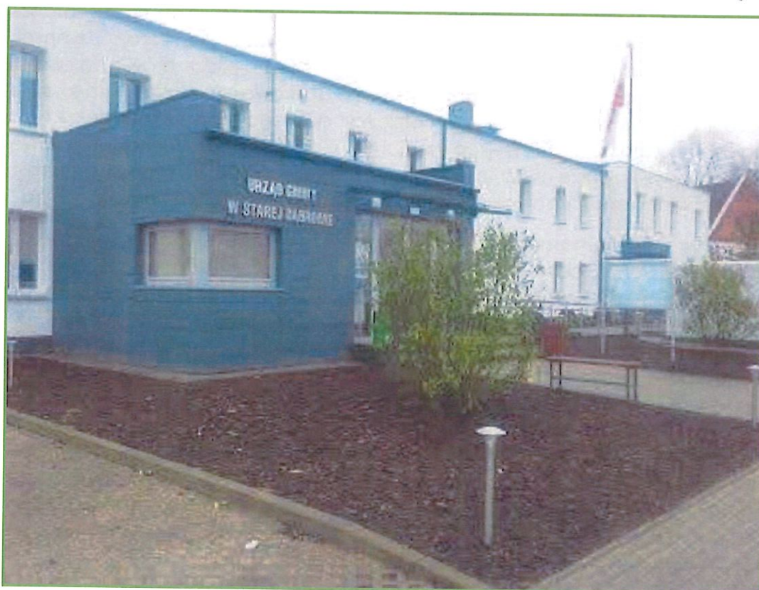
Rycina 8 Budynek Urzędu Gminy Stara Dąbrowa
