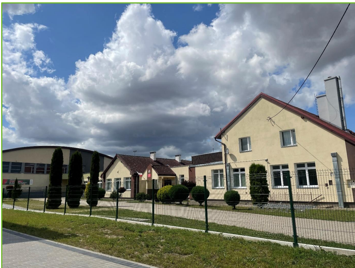
Rycina 9 Budynek Zespołu Szkolno-Przedszkolnego w Starej Dąbrowie
