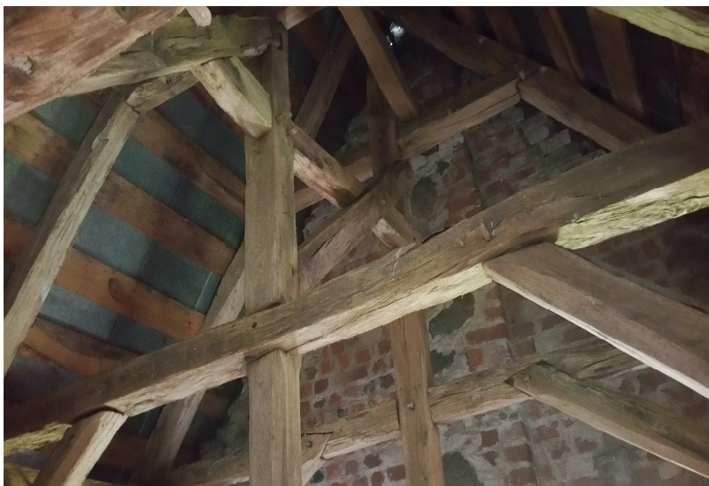
Zdjęcia 1. Widok elementów więźby dachowej
