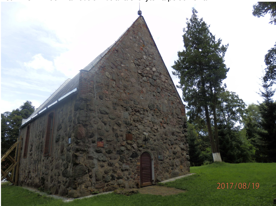
Fot. 11.4. Widok na elewację wschodnią szczytową.
