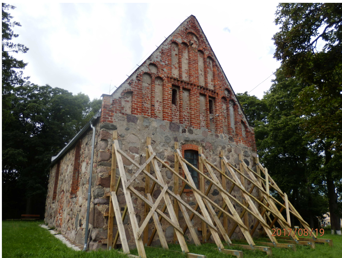
Fot. 11.1. Widok na kościół - ściana szczytowa zachodnia
