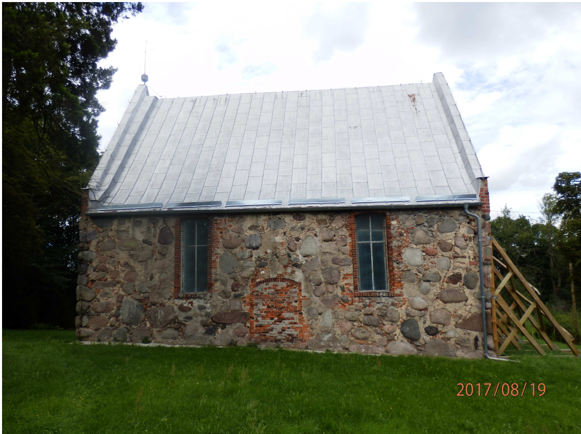
Fot. 11.3. Widok na kościół - ściana szczytowa południowa
